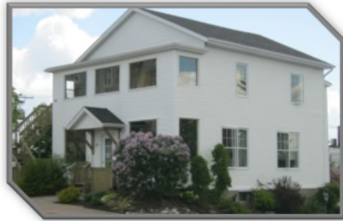
Résidence La Giboulée
